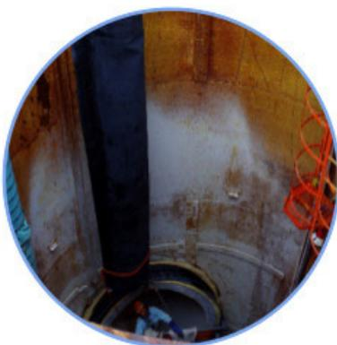
Einschieben einer gefalteten kissenförmigen Rohrblase
