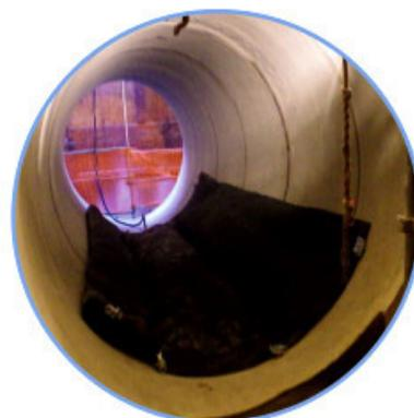
Positionieren – kissenförmige Rohrblase sollte horizontal positioniert werden
