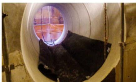
**Platzierung – Pillow Plug sollte horizontal positioniert werden**
