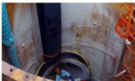
**Einsetzen eines gefalteten Kissensteckers**
